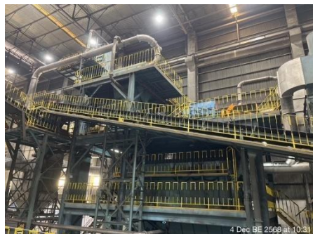
ภาพที่ 2-7 ระบบดูดอากาศ (ระบบปิด) ในบริเวณที่มี กระบวนการทำแบบทราย
