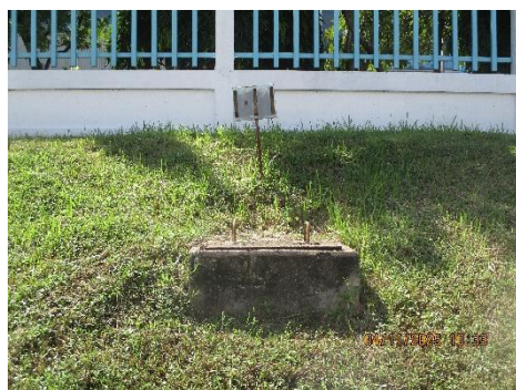
ภาพที่ 2-13 บ่อตรวจวัดคุณภาพน้ำ (Inspection manhole)
